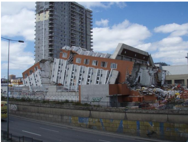
Das umgestürzte „Edificio Alto Río“ in Concepción
